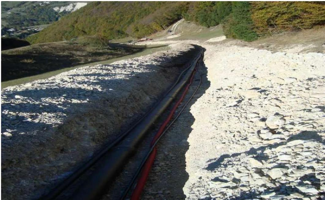
Posa tubazione in ghisa antisfilamento, fibra ottica, cavi Mt in alluminio (240mmq), cavo dati.
