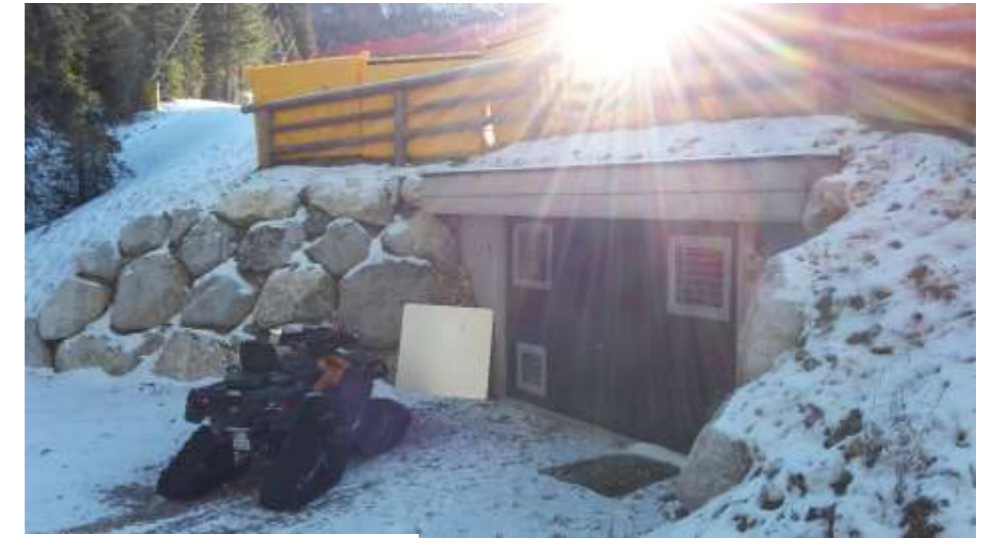
INGRESSO LOCALE POMPE
