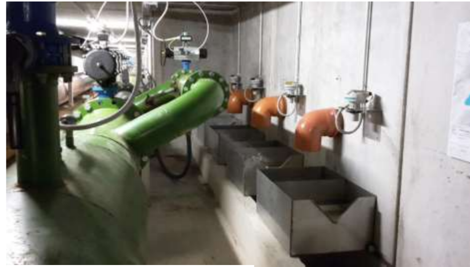
VASCHE RACCOLTA DRENAGGI
