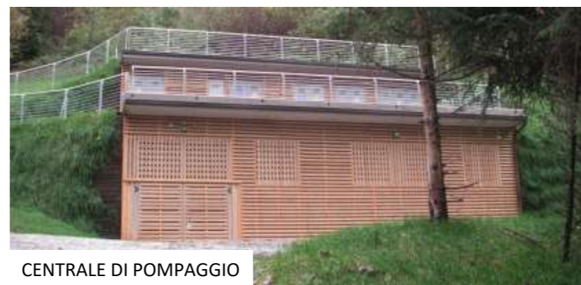
CENTRALE DI POMPAGGIO
